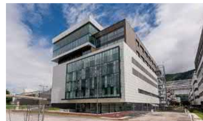
La plateforme photonique du CEA de Grenoble (38).
