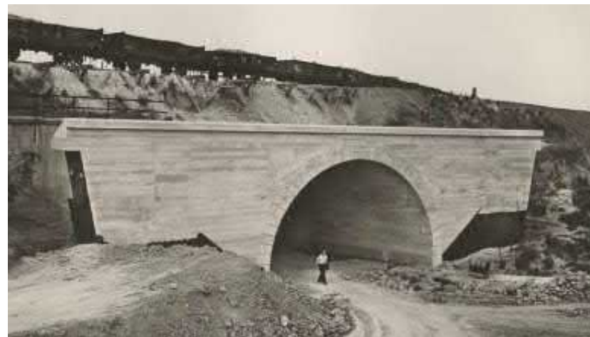
Construction du pont Venizélos à Montigny-lès-Metz en 1945. Les bureaux de ce chantier deviendront au fil des années le siège opérationnel de la Direction générale.
