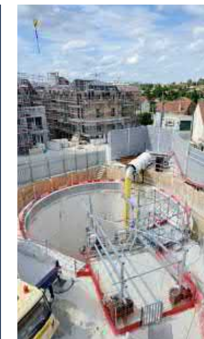
Vue aérienne d'un ouvrage annexe de la Ligne 15 lot T2C.
