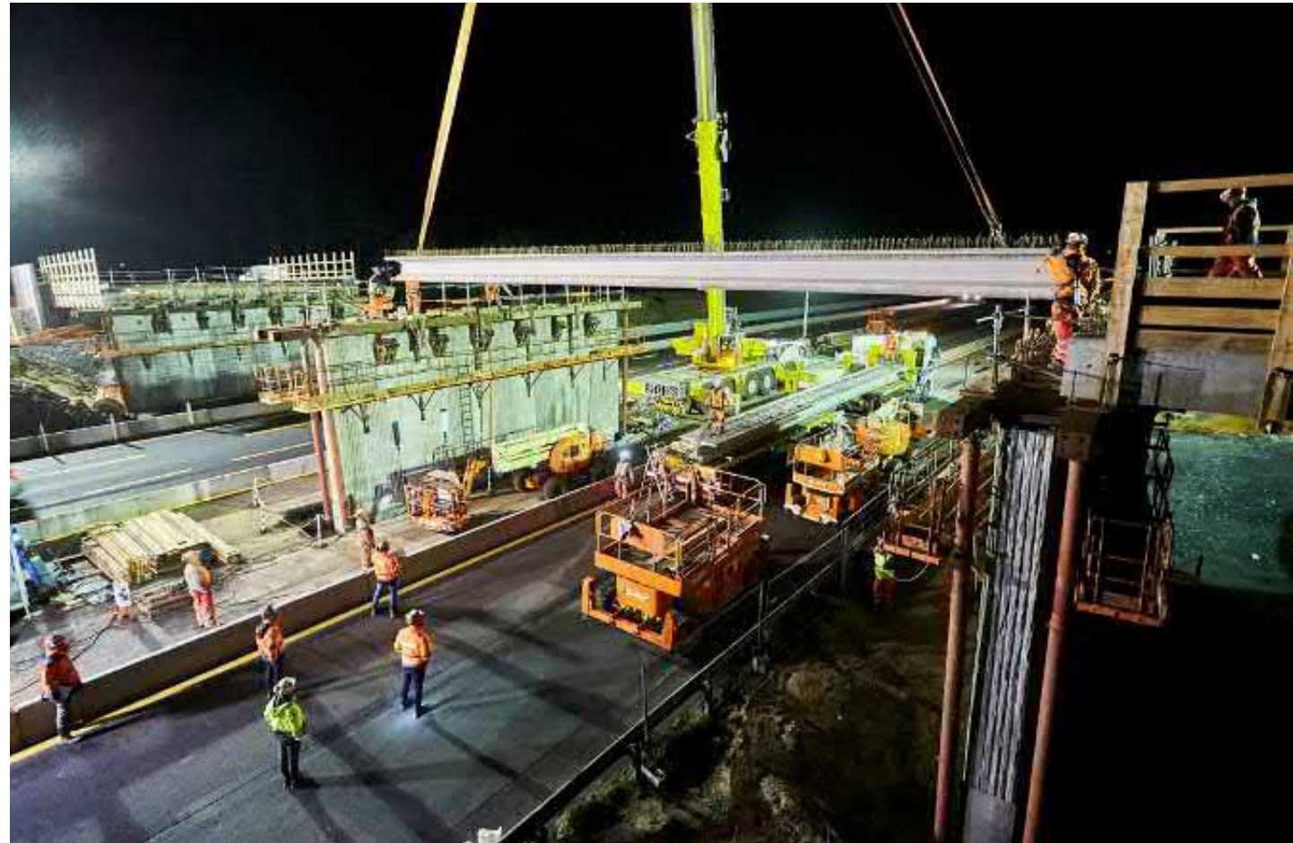
Mise à 2 x 3 voies de l'A63 – Bayonne (64).
