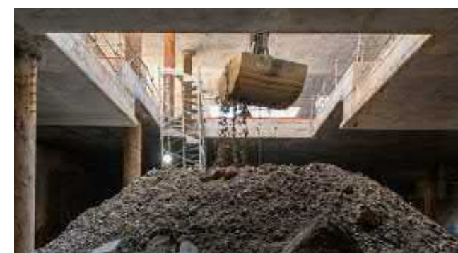
Les déblais du chantier du métro de Lyon viennent combler une carrière qui se trouve près de l'aéroport de Lyon Saint-Exupéry : 2 millions de m 3 sont nécessaires et le chantier du métro y contribuera à hauteur de 225 000 m 3 .
